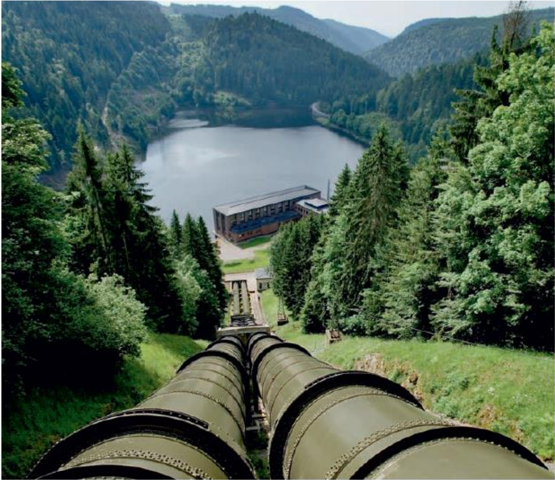
الشكل (4) صورة لأنابيب الرفع والتفريغ.
