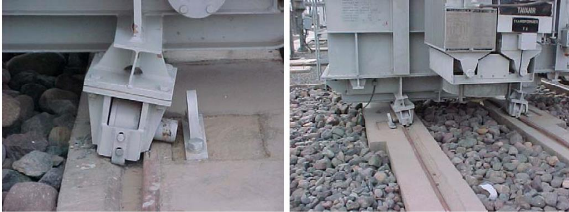
الشكل (7) خروج قواعد المحولات عن سكة التثبيت
