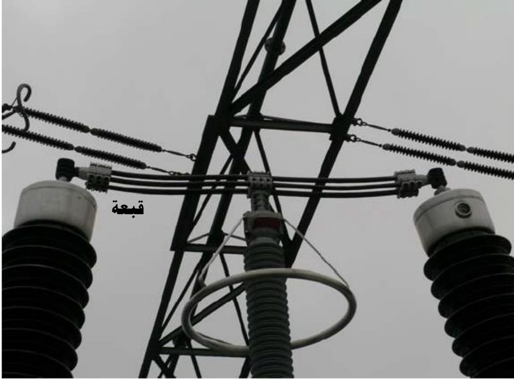
الشكل (10) ربط تجهيزات المحطة (نطور واحد) مع بعضها البعض
