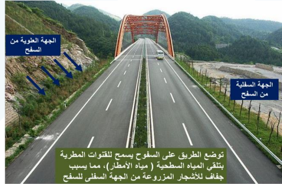
قص السفوح وتحميلها بالردميات يؤدي إلى تنشيط عمليات الإنهيارات الترابية
