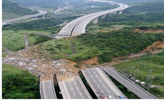
قص السفوح وتحميلها بالردميات يؤدي إلى تنشيط عمليات الإنهيارات الترابية
