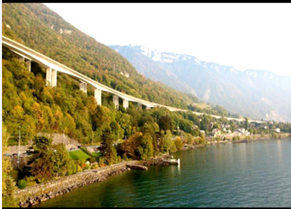
بناء الجسور المقامة على ركائز
