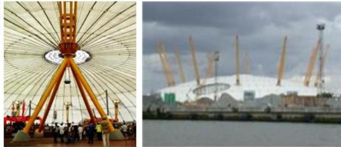
الشكل (1-46): الإنشاء المشكل للخيمة معلق بواسطة 12 عموداً من الفولاذ بارتفاع 100 متر، ونسيج السقف ذو
