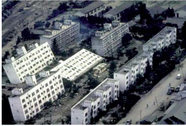
الشكل (2-79): الإسالة (التميع) في تربة التأسيس تسبب انهيار الأبنية (نيكاتا - اليابان)
