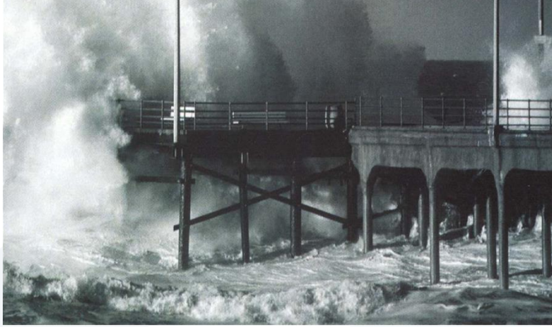
الشكل (2-34): تعرض المنشآت البحرية لأموج خطيرة (أعاصير فلوريدا الجنوبية)
