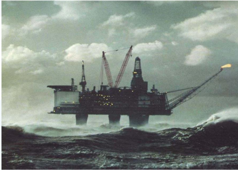
الشكل (2-35): قوى الأمواج تمثل حمولات ديناميكية كبيرة على منصة بحرية (استخراج النفط)
