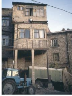
Erevan, Arménie zone de forte sismicité
