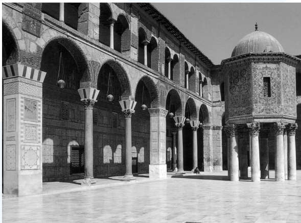
الجامع الأموي في دمشق: الصحن المحاط برواق تتناوب فيه الدعائم والأعمدة وتعلوها أقواس نصف دائرية
