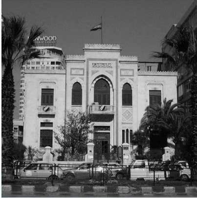
دمشق: مبنى مصلحة مياه عين الفيحة (1942)
