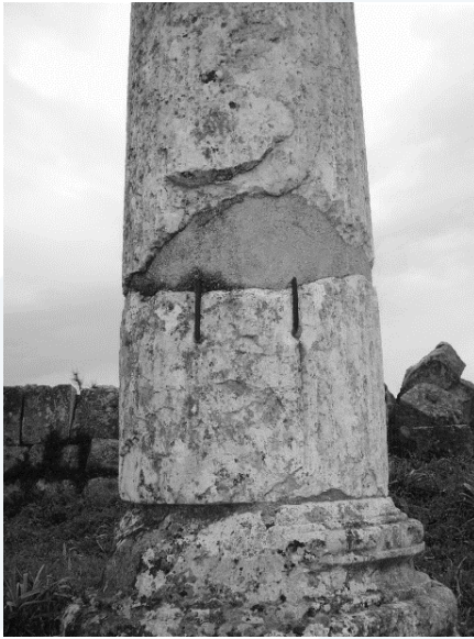
شارع الأعمدة في أفيصا: الترميم باستخدام البيتون والكلابات المعدنية
