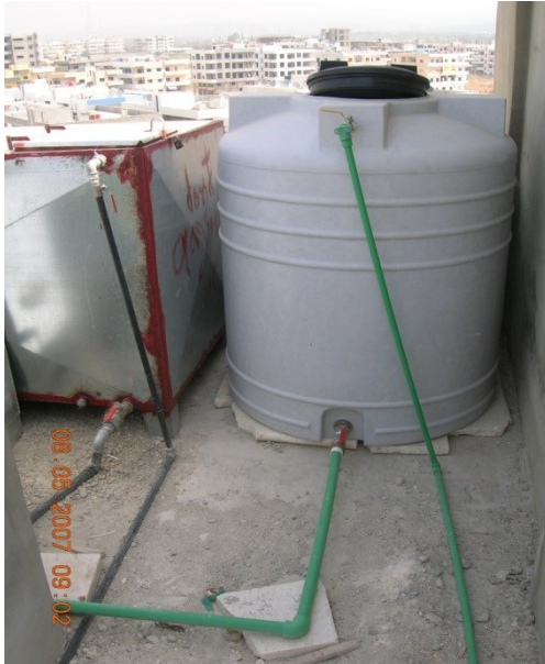
خزانات المياه على السطح
