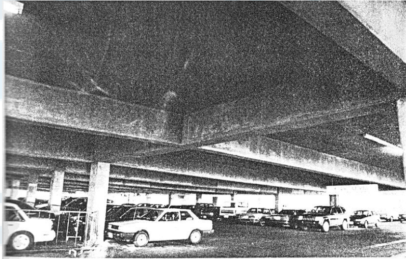
الشكل ( 2 - 9 ) : بلاطة مليئة عاملة باتجاهين مستندة على جوائز بارزة (كراج سيارات)
