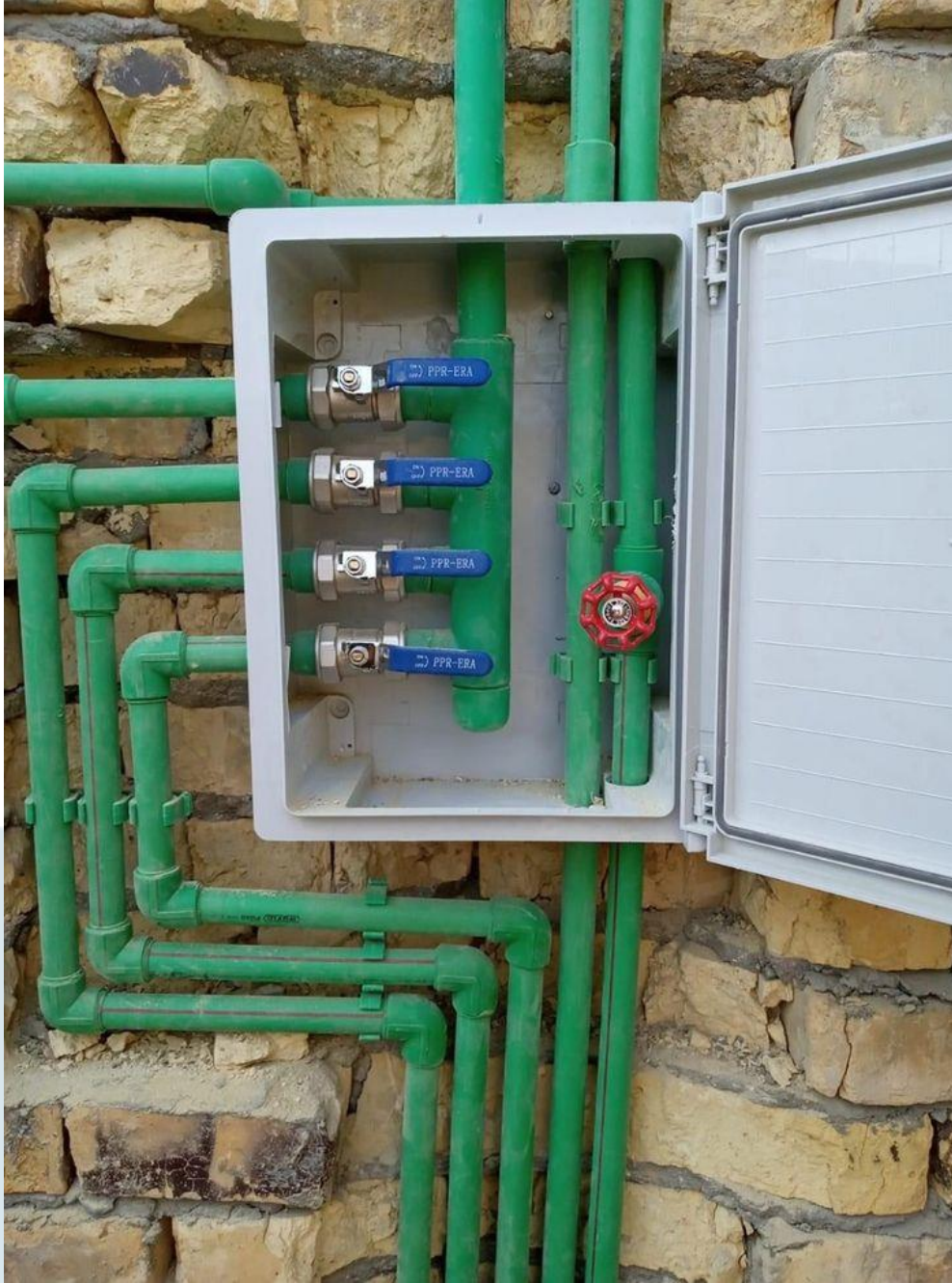
تركيب مجمع للأنابيب
