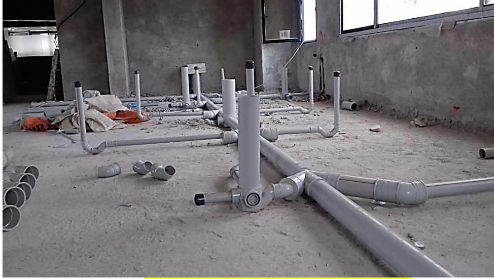
شبكة صرف صحي أرضية فوق البلاط
